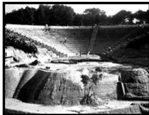
Teatro Griego en construcción, 1931, AFC.
