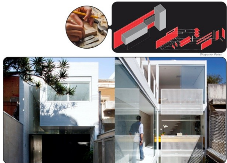
Casa 4x30, CR2arquitectura y FGMFarqs, 2009.
